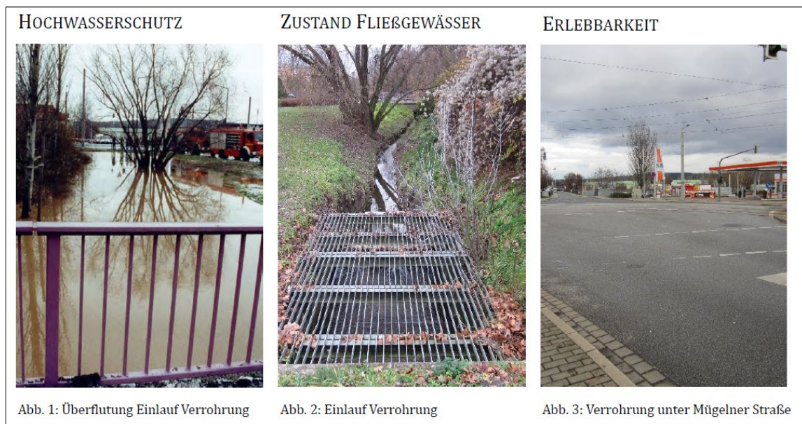
Abbildung 1: Gründe für die Offenlegung des Geberbachs (1. Abschnitt der Maßnahme)
